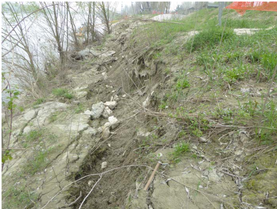
Foto 3: disesto spondale a monte dell'immissione del canale Fossetta nel fiume Po
