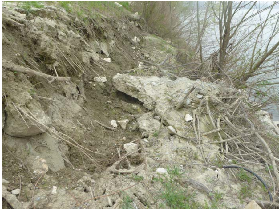
Foto 2: dissenso spondale a monte dell'immissione del canale Fossetta nel fiume Po
