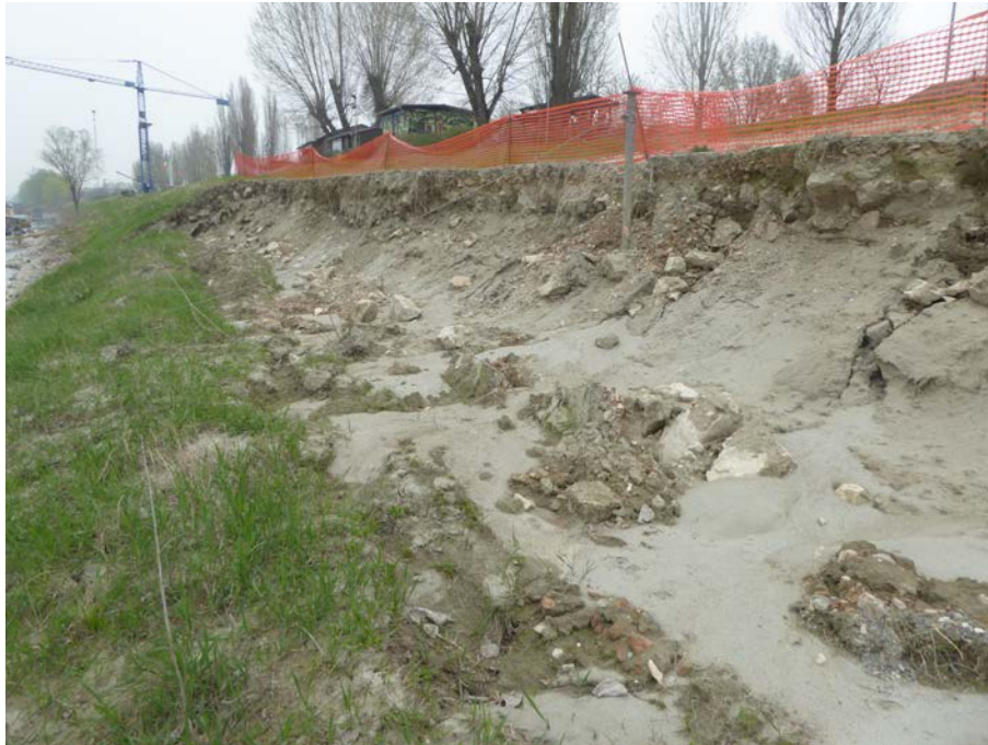
Foto 1: dissenso spondale a valle dell'immissione del canale Fossetta nel fiume Po
